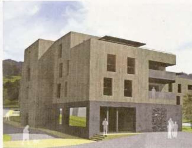
Auf der «Husmatt» steht das Grossprojekt bereits im Bau, vorne gegen das Dorf hin (Bild) wird auch ein Restaurant realisiert.
