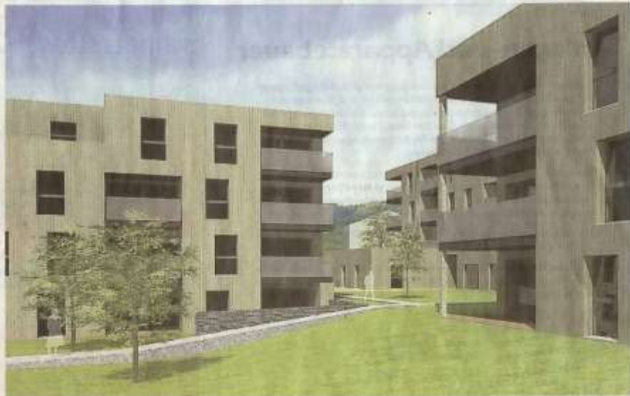
38 Miet- und 11 Eigentumswohnungen: Verteilt auf vier Gebäude (im Vordergrund rechts jenes mit den Eigentumswohnungen), sollen sie zu Vorzugsbedingungen einheimischen Interessenten abgegeben werden.
