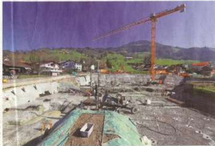
Blick von einem der beiden Baukräne in die Grossbaustelle Husmatt. Archivbild Urs Affolter
