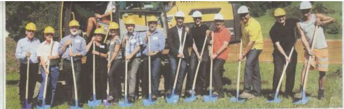
Spatenstich erfolgte: (von links) Präsident der Katharina & Karl von Rickenbach-Stiftung Albin Marty, Stiftungsräte Josef Marty, Ruedi Meier, Margrit Wymann, Christa Müller, Urs Affolter und Roland Ullmann, Architekten Josef Pfyl und Urs Baumann sowie Tiefbauingenieur Remy Gürber, Geschäftsführer der Firma Börgi Tiefbau AG André Brugger und ebenfalls von der Firma Börgi Tiefbau AG Beat Schröter, Bauleiter Peter Betschart. Im Bagger: Urs Inderbitzin. Bild Sandrine Hedinger
