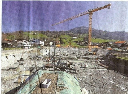
Blick von einem der beide Baukräne in die Grossbaustelle Husmatt.
